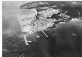
辺野古の工事現場(琉球新報より)
