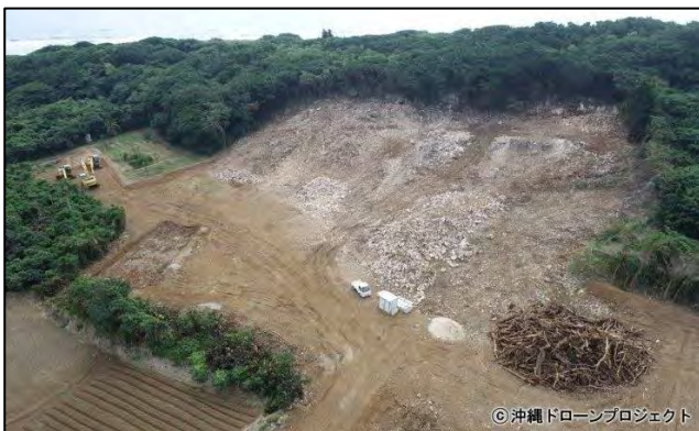
熊野鉱山 20.11.27 沖縄ドローンプロジェクト撮影 設計変更申請で新規参入した業者の鉱山だ
