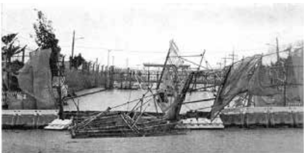
台風 24 号で壊れた高さ4mの車両入り口の柵 (2018.9.30 沖縄タイムス)
