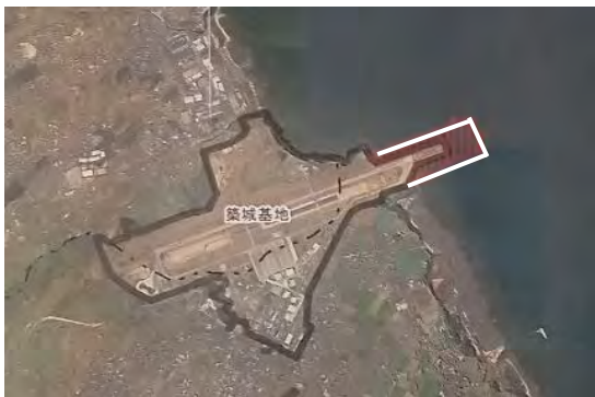
海に突き出た右の白線の部分が、滑走路延長部分
