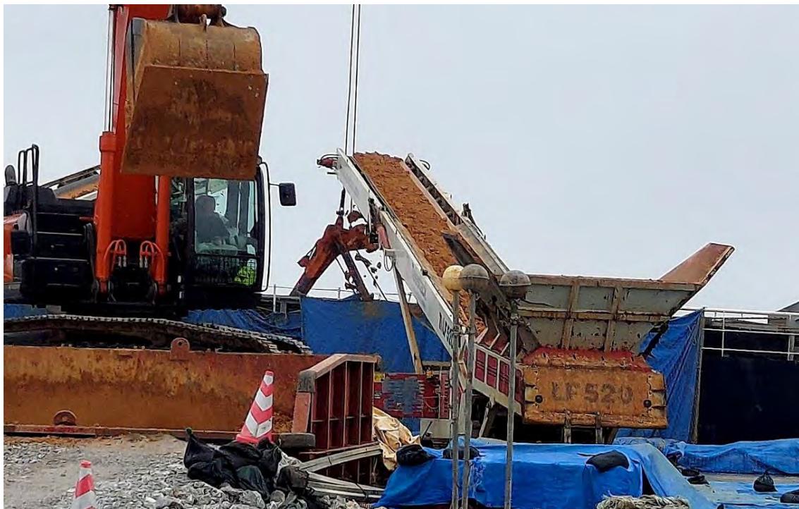
塩川港の様子。ダンプが運んできた土砂(この日は赤土)は、ベルトコンベアで船に積み込まれる。
