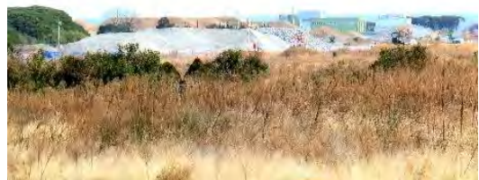
敷地の外から見える工事の様子
