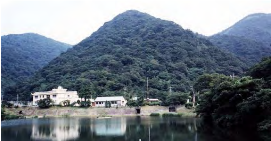
富野弾薬庫の写真。山(丸山)をくりぬいて 13 本のトンネル式の弾薬庫を建設。面積 1,667,088 m 2 で、危険度「1」の表示が 5 本ある。
