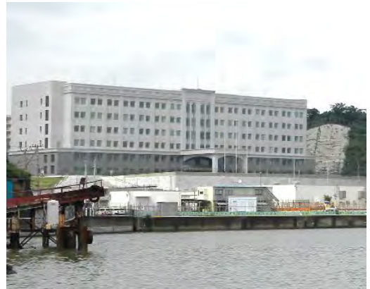
完成間際の「海洋作戦センター」
